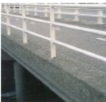
Betonnen rand bij een viaduct ...
